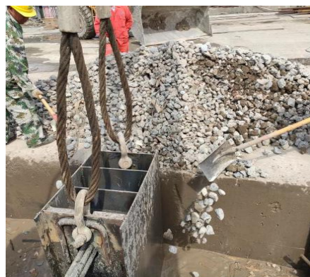
图10 钢箱背部回填实物图
