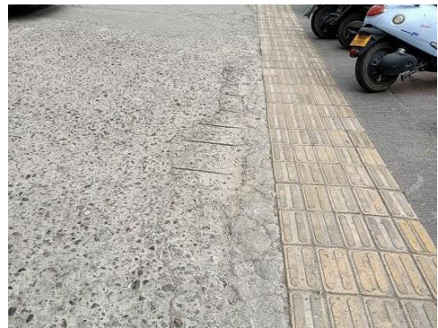
图2 钢筋暴露
