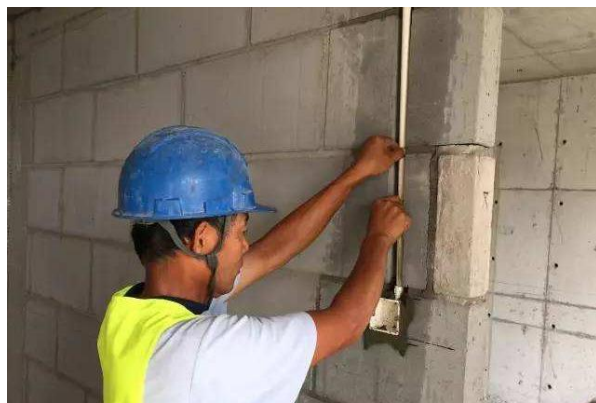
图1 建筑电气管线安装
