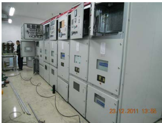
图二为配电室施工过程图
