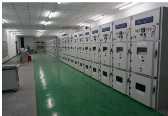
图三为配电室施工过程图
