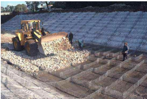
图2 河道治理工程中应用雷诺护垫
