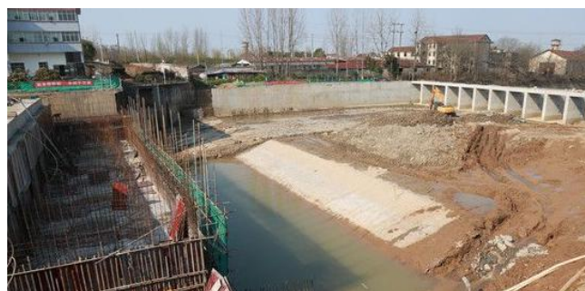
图2 泵站水闸施工
