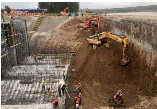
图1 泵站水闸开挖
