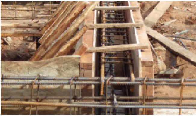
图一 地下连续墙
