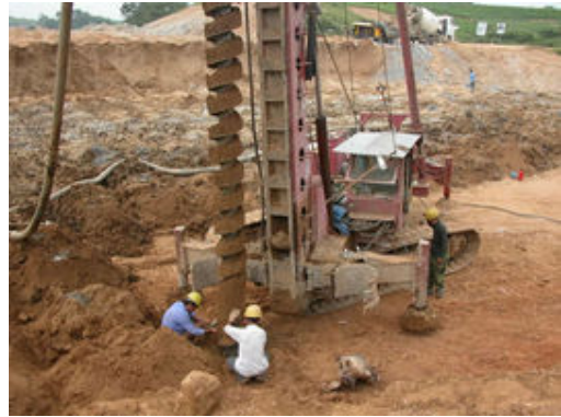
图2 CFG桩施工
